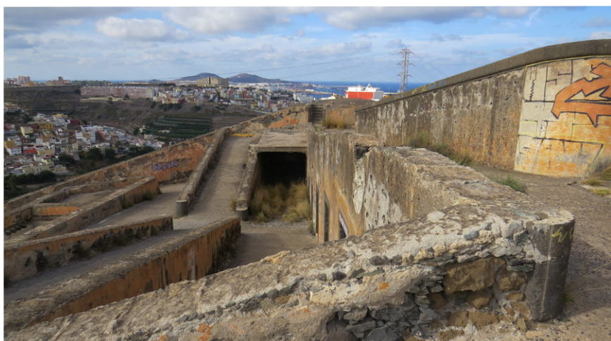
Batería de San Juan. Estado actual.
